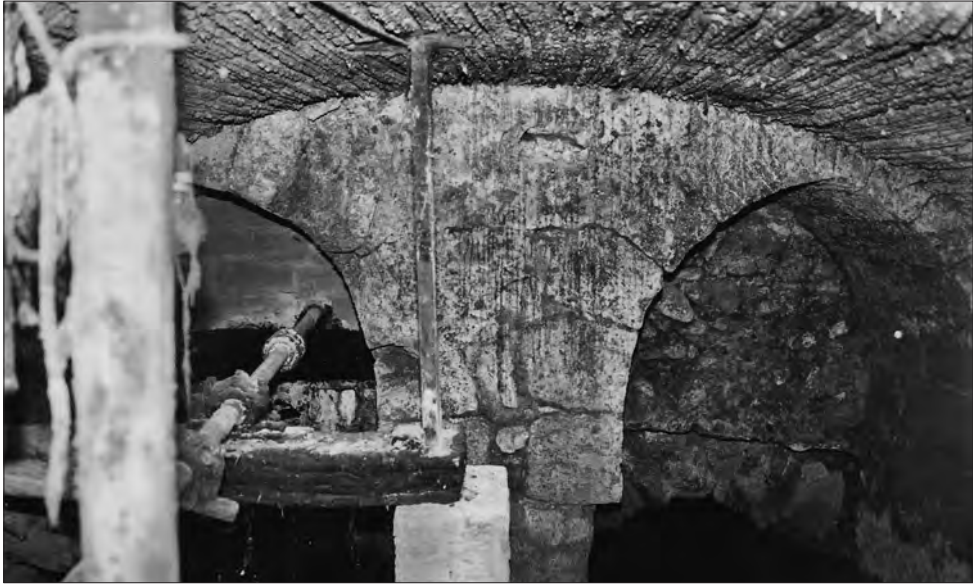
□ Figura 5: Sala dels carcaus. Molí de la Torre.
